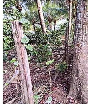
Foto 2: Se observa que la circulacion esta en mal estado necesita ser sustituida. MODULO 2
