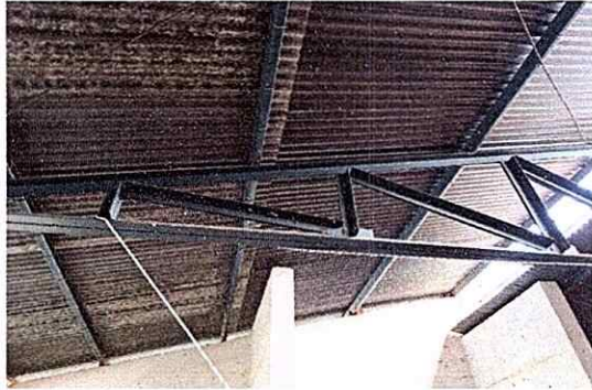
Foto1: Se observa que la costanera esta en buen estado pero es necesario el cambio de laminas. MODULO 1
